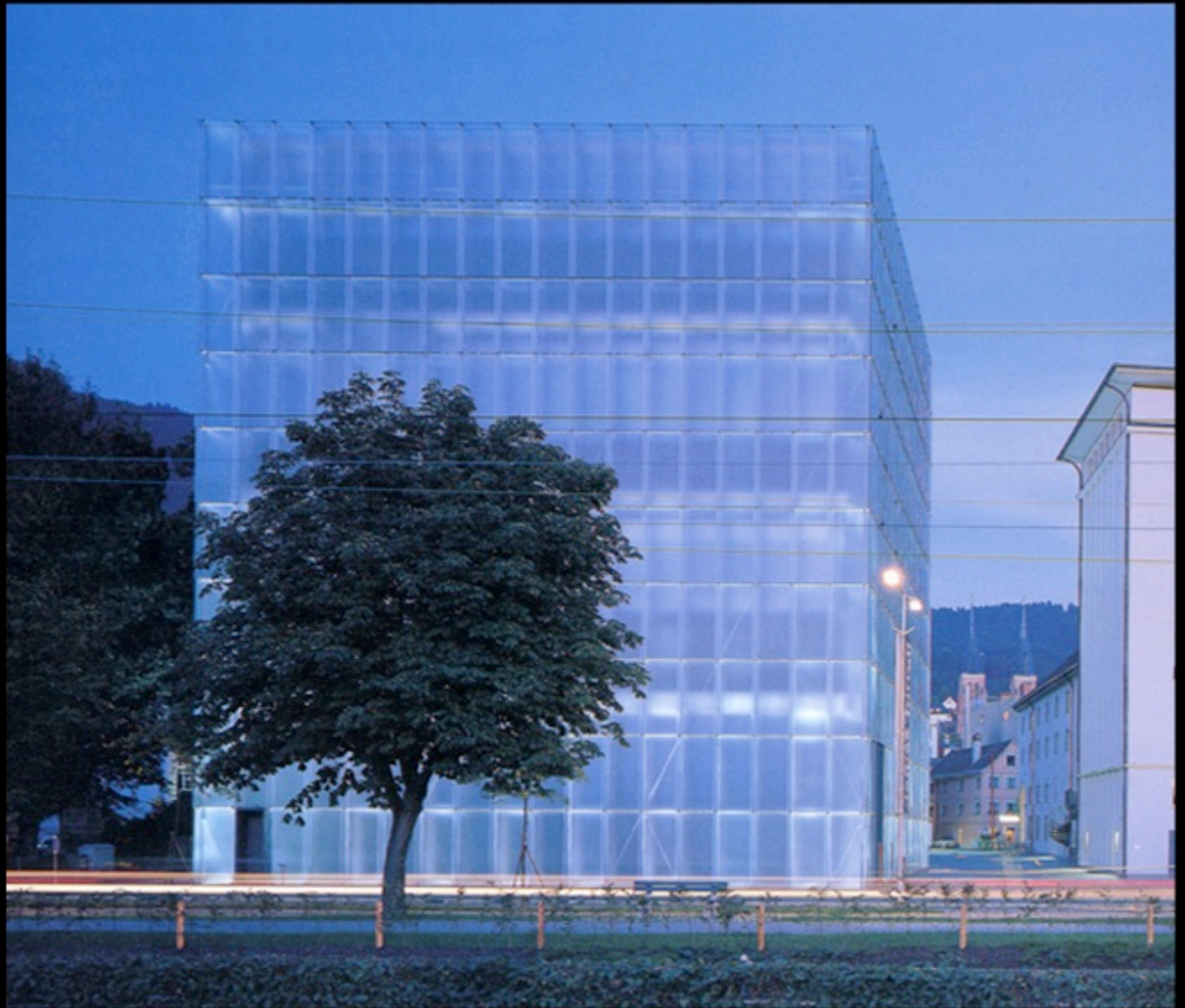
Le musée d' Art Moderne à Breguenz, P. Zumthor , Architecte
