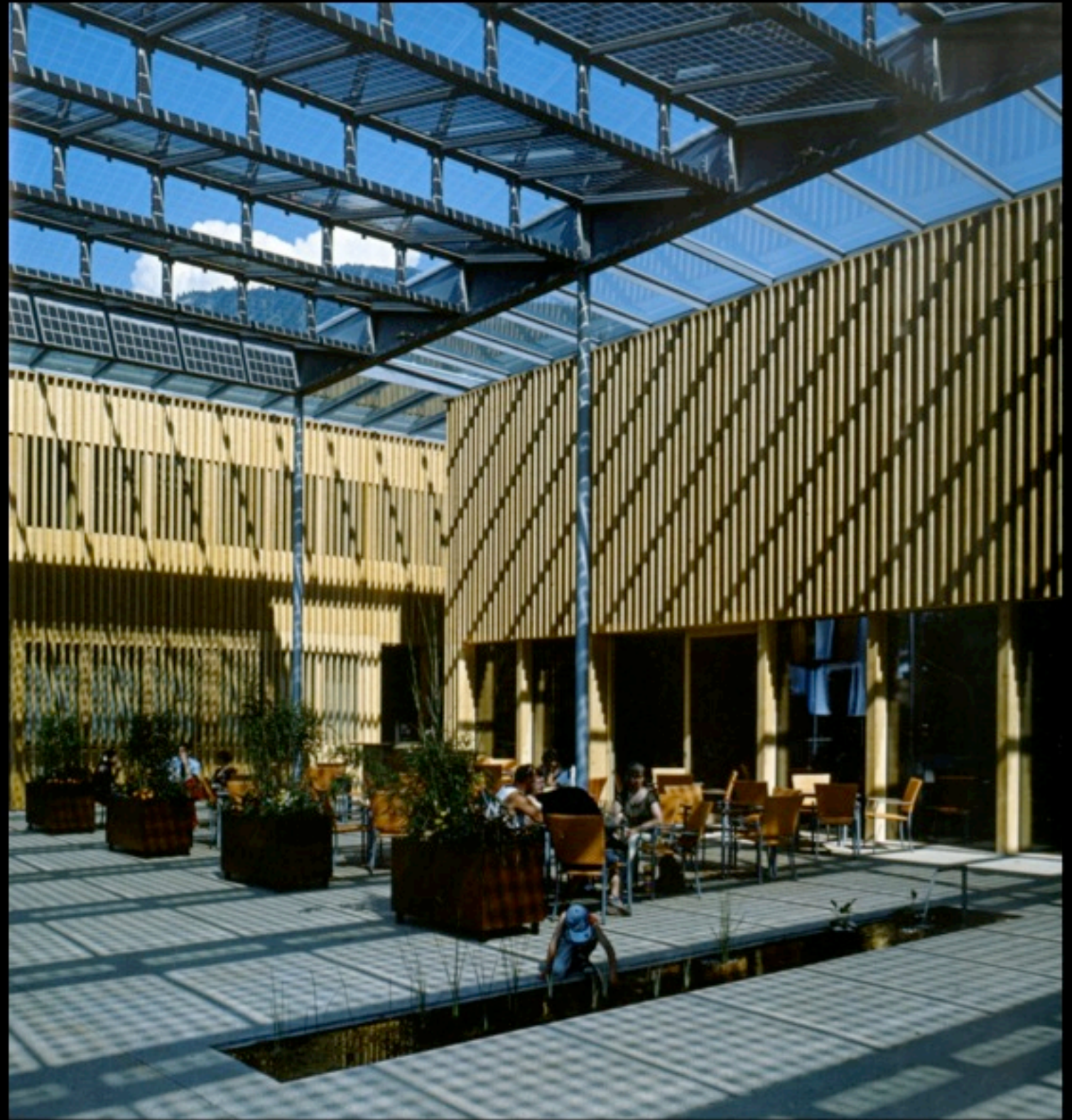
Centre communal de Ludesch, H. Kaufmann, Architecte
