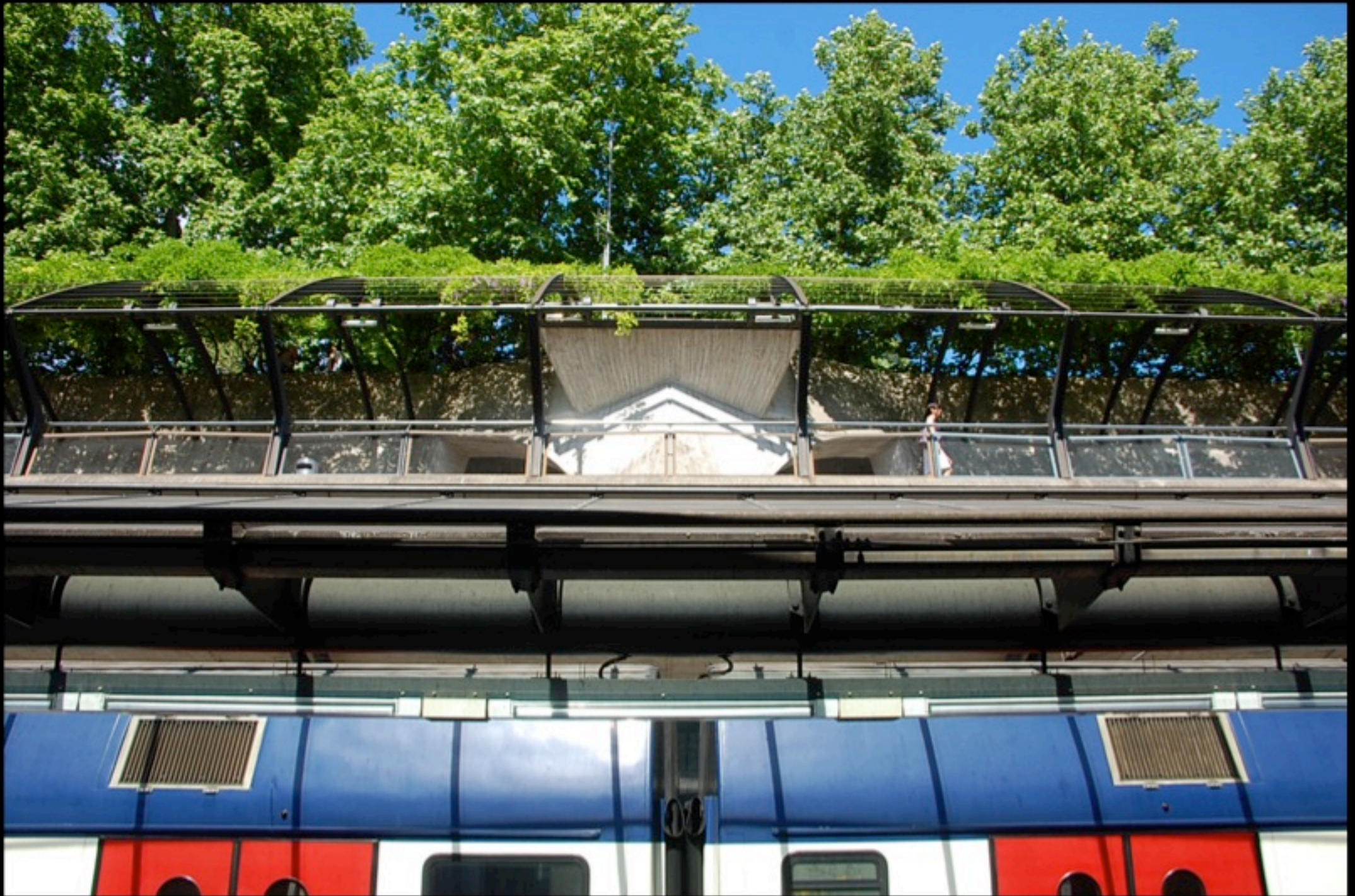
Gare ferroviaire de Zurich Stadelhofen, S. Calatrava
